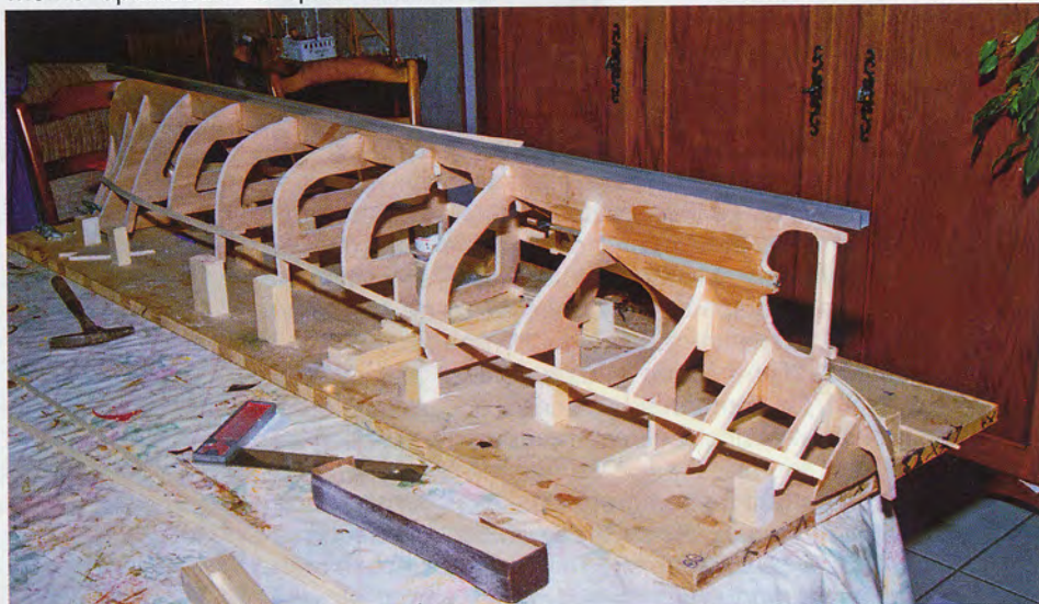
Ossature sur le chantier.
